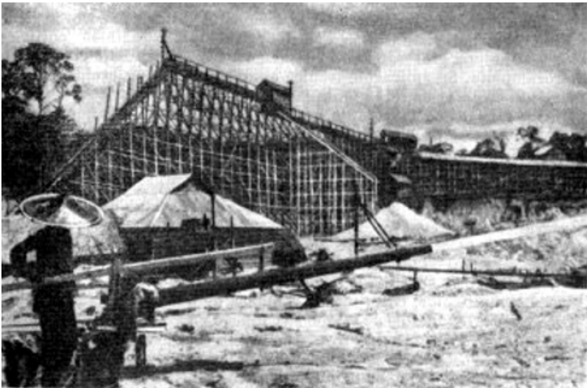
Figura 18.4 Depósitos de arenas estanníferas en la Península de Malaca. La masa mineral se lava con hidromonitores (lanzas de agua). El barro líquido obtenido se hace escurrir por zanjas especiales. Placer de Iogore-Bagrú (año 1940)
