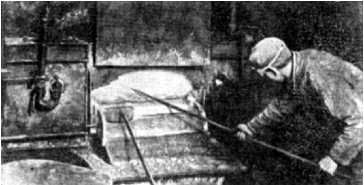
Figura 33.3 Horno para fundir mineral de wolframio
