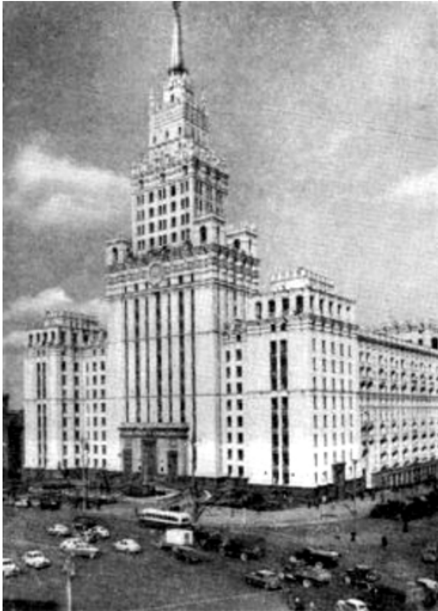
Figura 27.1 Edificio de gran altura en Moscú, en la plaza Lérmontov, revestido de calizas blancas de las cercanías de Moscú
