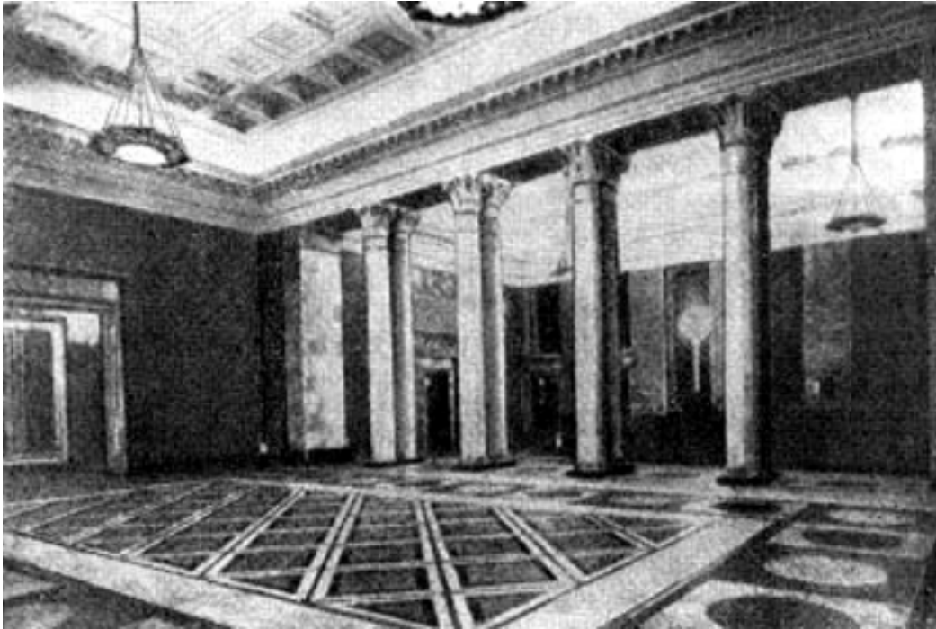
Figura 14.10 Estación "Bielorruskaia" del metropolitano de Moscú. Las columnas son de mármol blanco; las paredes y el piso de mosaico de mármoles del país dotados de vivos colores
