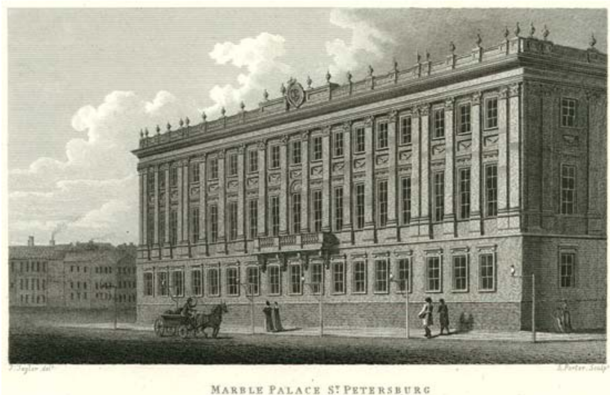
Figura 14.7 Palacio de Mármol de la filial del Museo de V. I. Lenin en Leningrado. A excepción del piso bajo (construido de granito), todo es de mármol ruso
