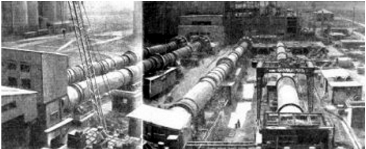
Figura 14.1 Vista general de una fábrica de cemento
