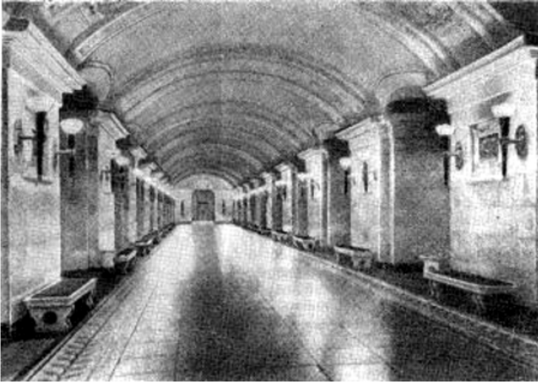
Figura 14.9 Estación "Oktiabrskaya" del metropolitano de Moscú. Las paredes están revestidas con mármol blanco de los Urales
