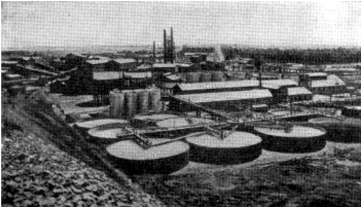
Figura 24.10 Cubas enormes en donde se disuelve el oro por el método de cianuración
